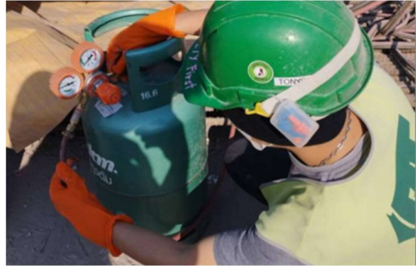
ภาพตัวอย่างการตรวจสอบชุดถังลม ถังแก๊ส
